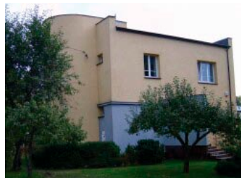
Tymczasowa siedziba szkoły przy ul. Słowackiego
